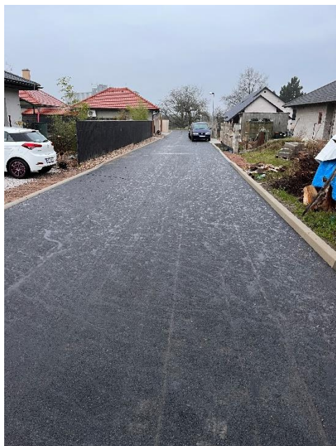
Nový stav po rekonstrukci
