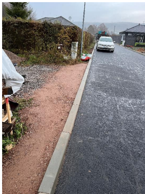
Nový stav po rekonstrukci
