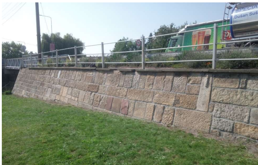
Opěrná zídka po rekonstrukci
