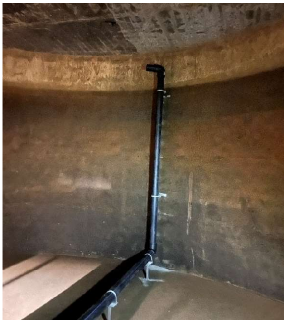
Pohled do vypuštěné akumulční nádrže v průběhu prací
