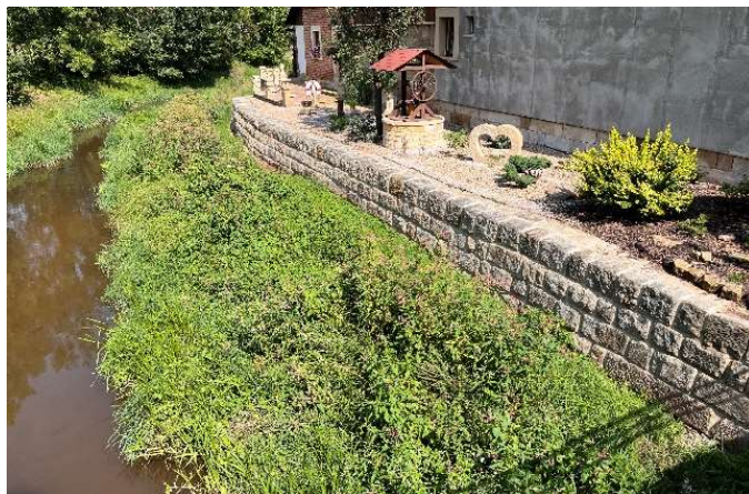
Nábrežní zídka po rekonstrukci
