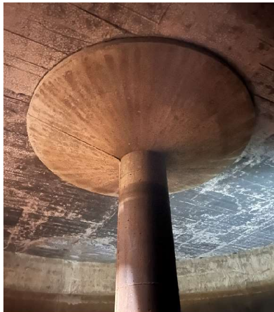
Nosný pilíř v akumulčních nádržích
