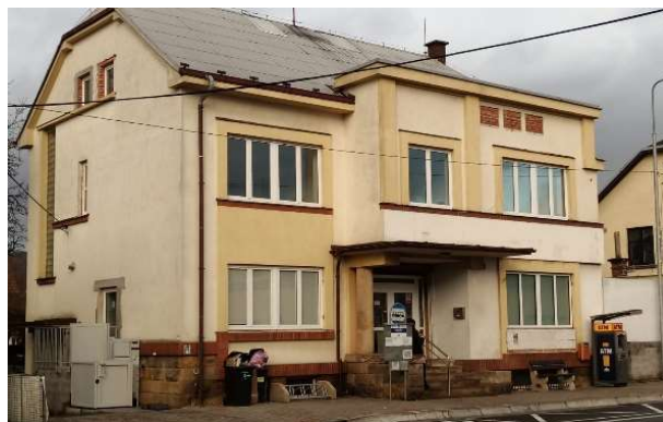
Pohled na stávající průčelí objektu z ulice T.G. Masaryka
