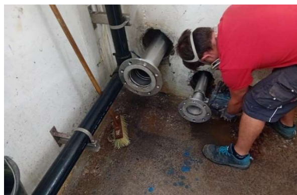
Montáž prostupů vodojem x akumulční nádrže
