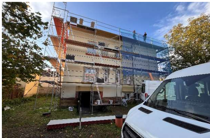
Probíhající práce na S straně
