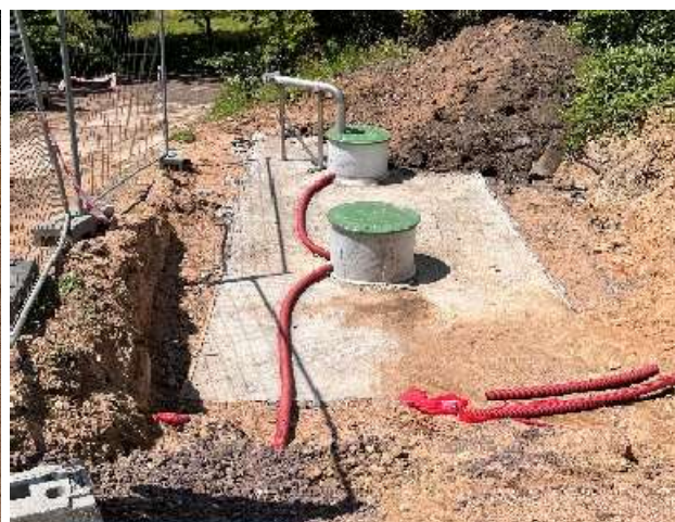
Sedimentační jáma s krycí betonovou deskou
