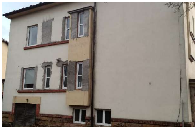
Pohled na stávající fasádu ze S strany
