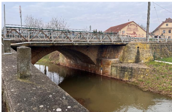
Původní stav lávky
